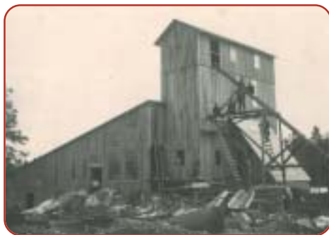
Anrikningsverk och krosshus innan branden 1948. Foto lånat av Lasse Westlund.
